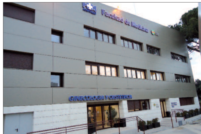
Nuevo edificio de HMM para consultas de Ginecología y pabellón docente.
